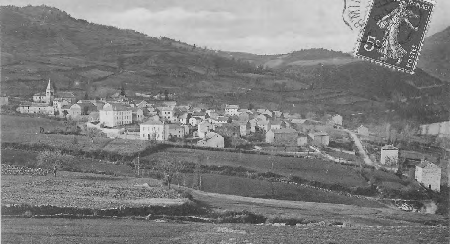
Edif. M. Trocellier, à Retournac (Haute-Loire).
